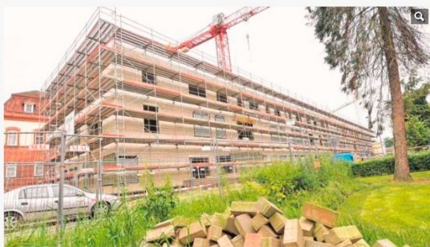
Der Blick auf Bremens teuerste Baustelle
