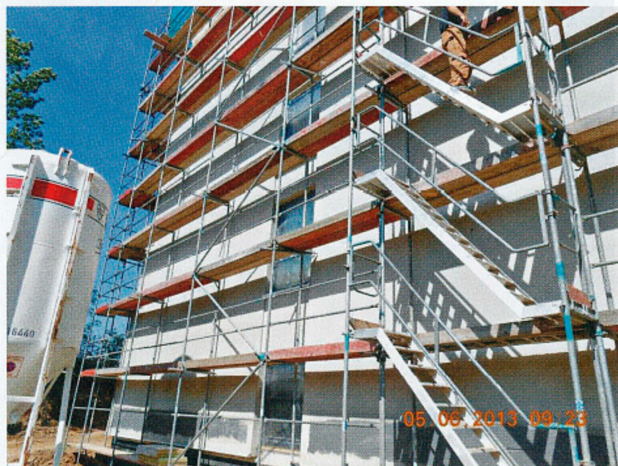
10 Auch das Arbeitsgerüst wurde nach den Vorgaben des Sachverständigen vorschriftsmäßig abgeändert.
